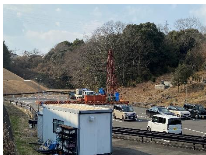
井戸 2本目掘削 IV B C Pの整備
