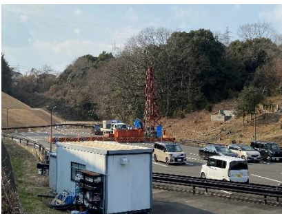
井戸 2本目掘削 IV BCPの整備
