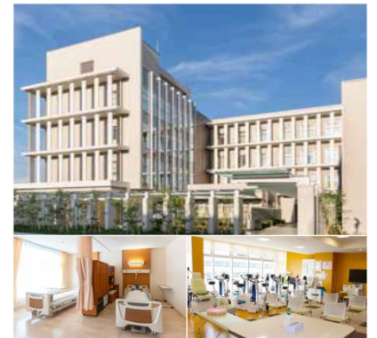
新病棟 (N館) 竣工
