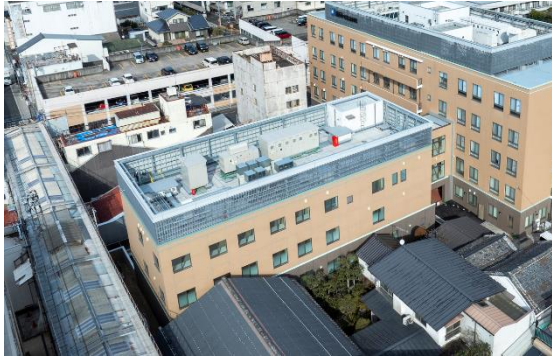
増築棟全景（南側より：右隣りは本館）
