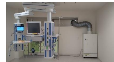
簡易陰圧装置4台設置
